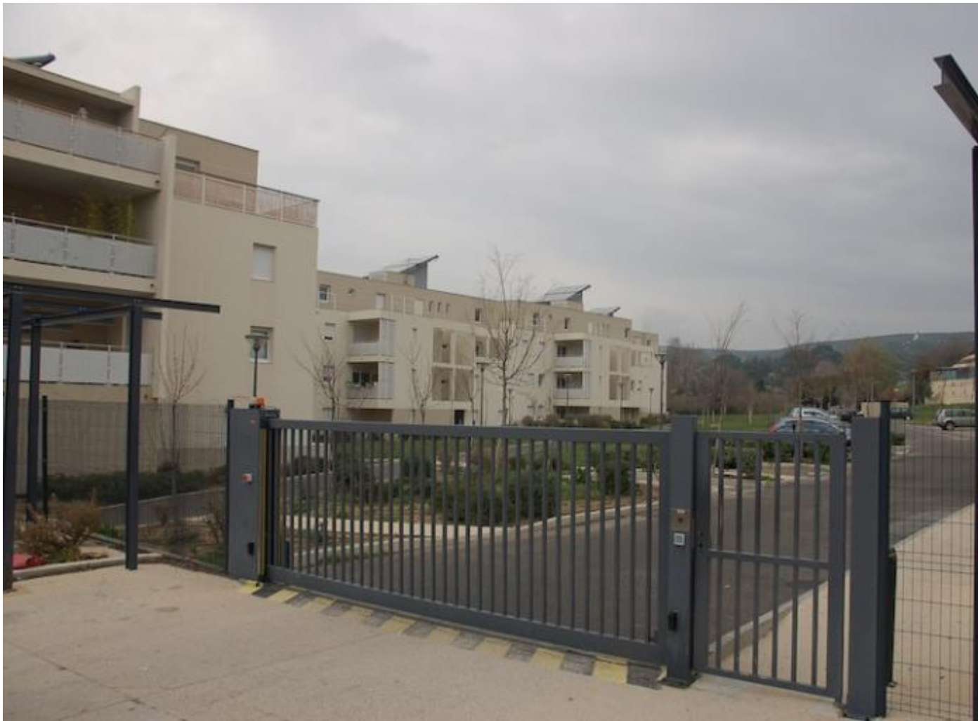
L'exemple type d'une des résidences fermées réalisées dans la ZAC, janvier 2014. © LF
