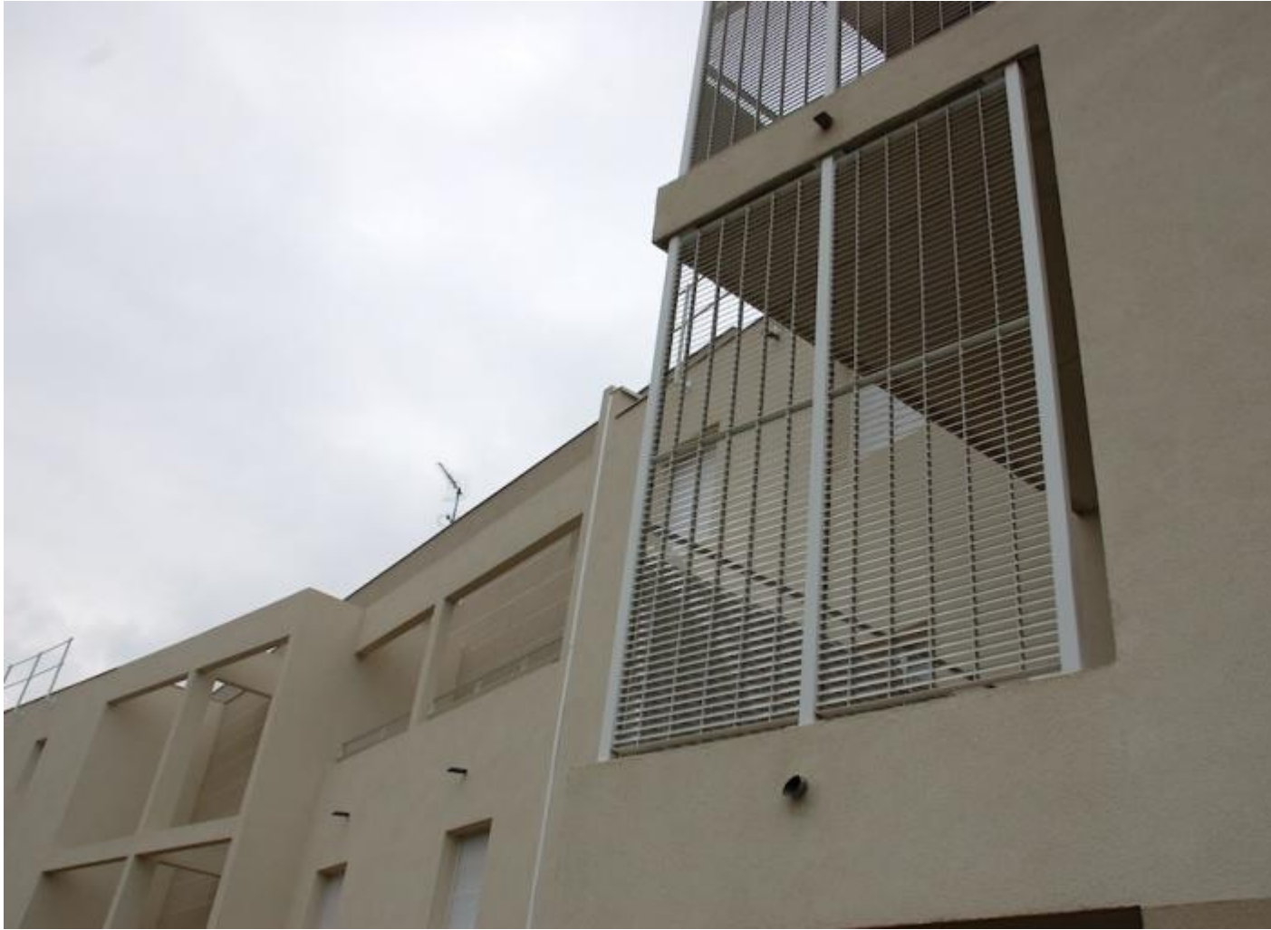
Grilles à tous les balcons © LF
